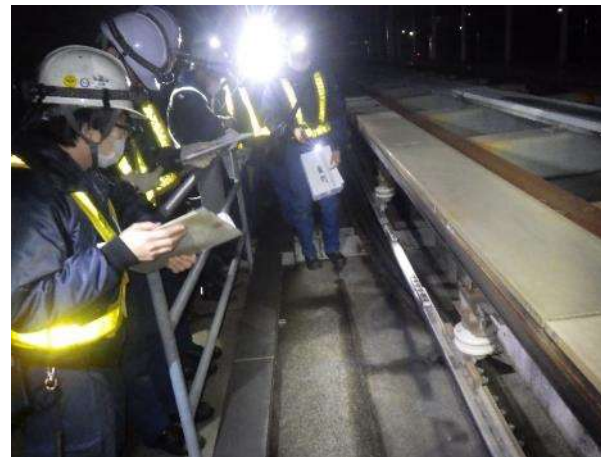
芸大通駅下り線セクション位置確認
