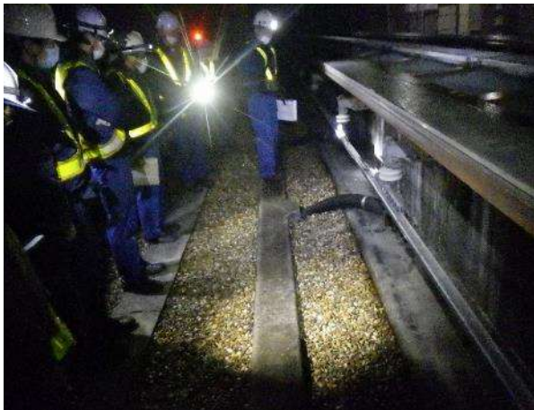
車庫内セクション位置確認
